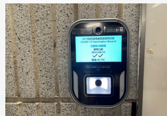
車場入口 掛牆安裝
